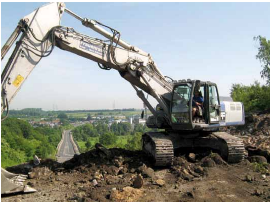
Herausforderung: Frauenrath-Maschinen auf schwierigem Terrain
