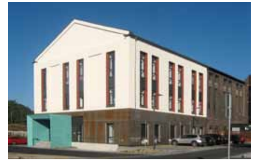
Sanierungsobjekt: die frühere Elektrowerkstatt EW1 in Hückelhoven
