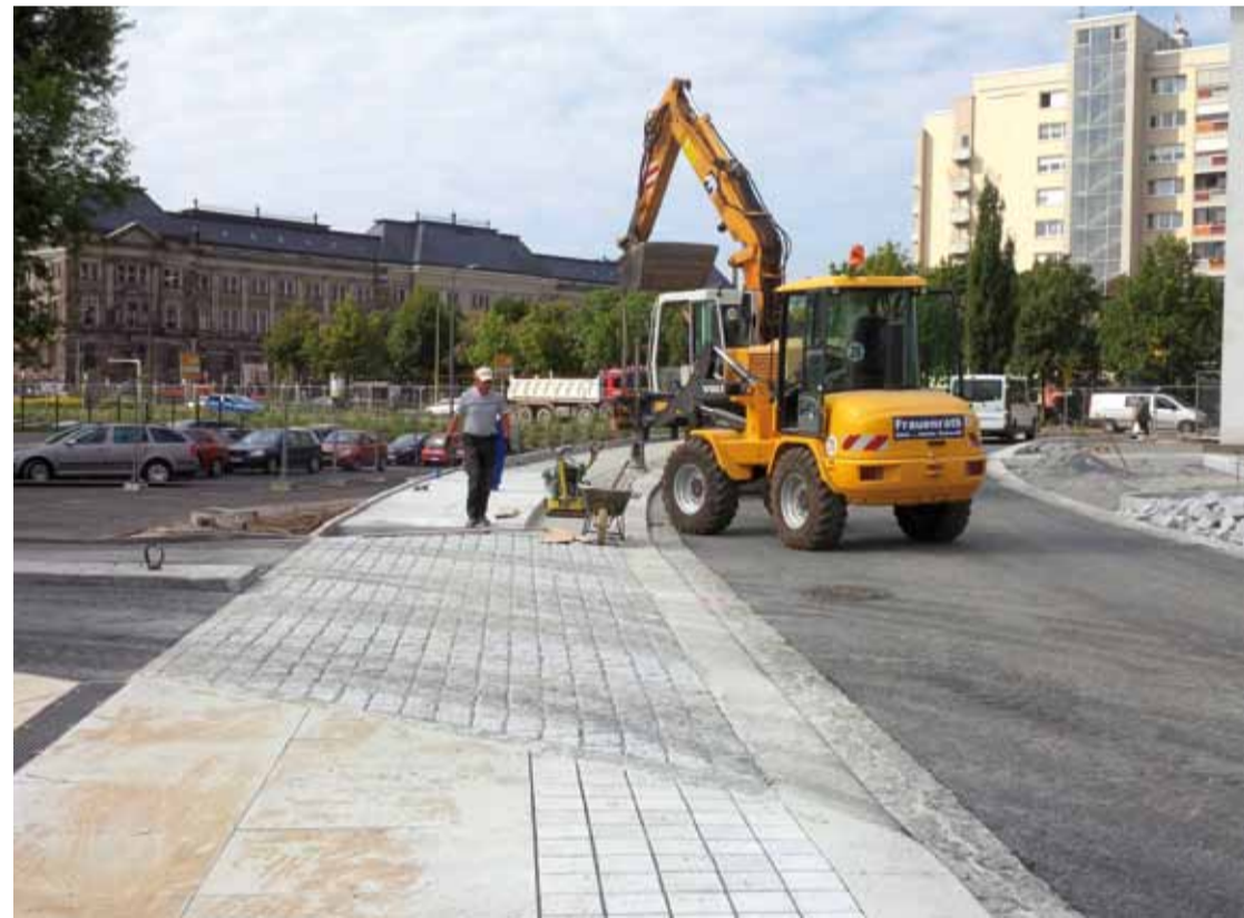
Frauenrath löst Parkplatznot nahe der Dresdner Staatskanzlei
