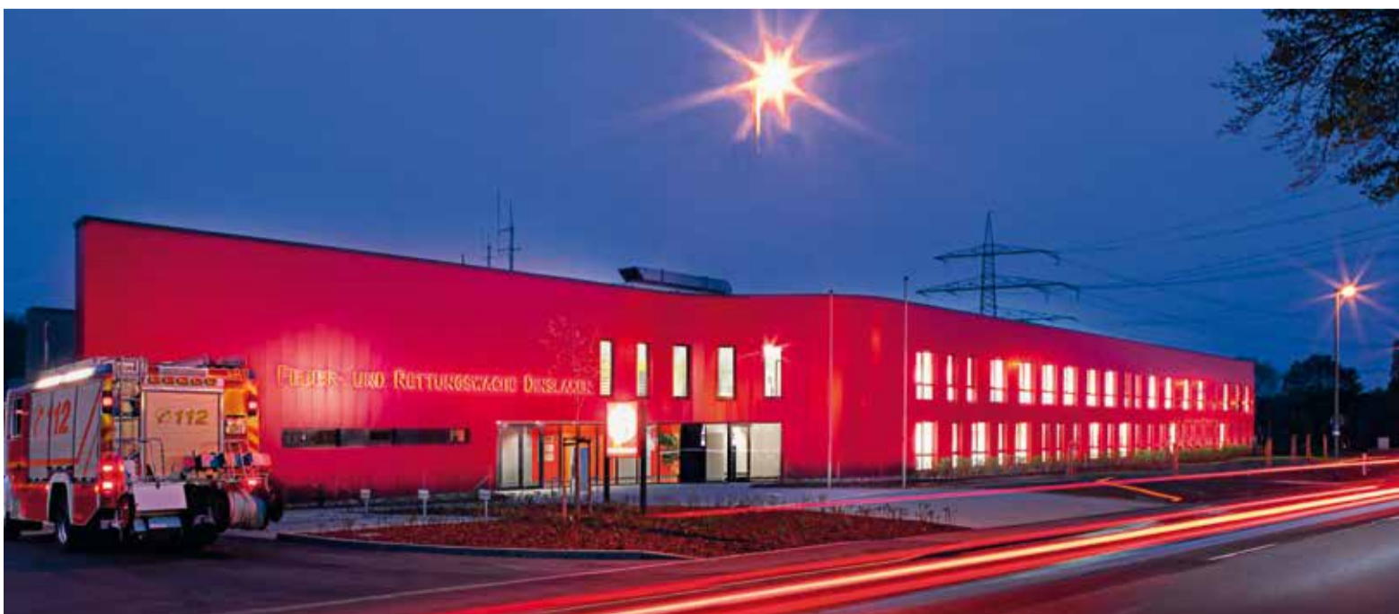
Zuverlässiges Facility Management für einen reibungslosen Betrieb: die Feuer- und Rettungswache Dinslaken
