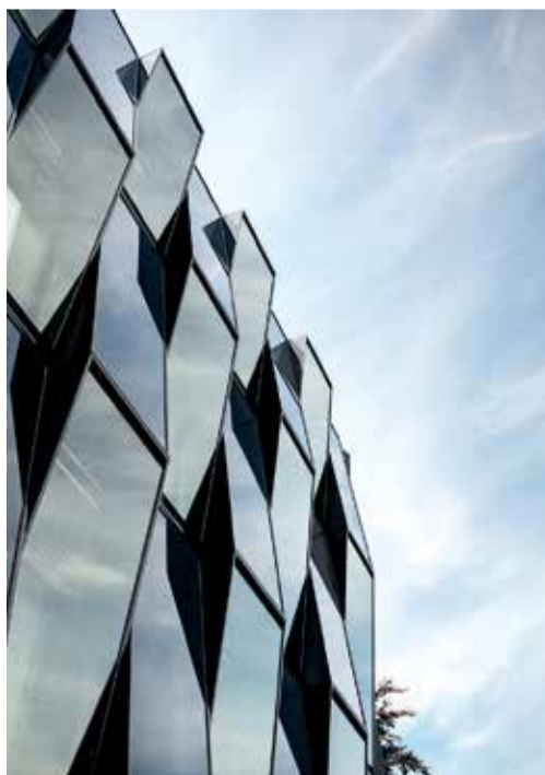
Photovoltaikmodule verleihen dem NEW-Blauhaus einen bläulichen Schimmer.
