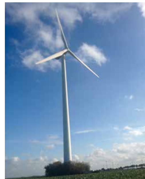
Auch 2015 setzt Frauenrath weiter auf erneuerbare Energien
